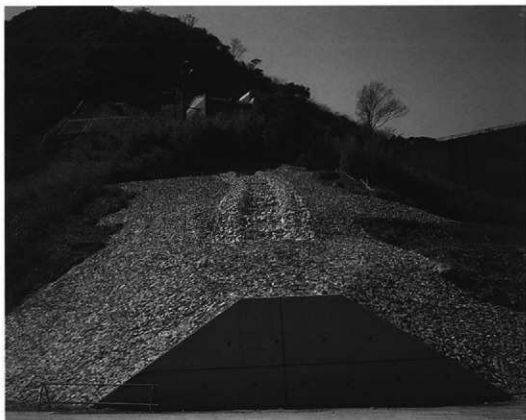
第305図 保存整備後の内ヶ磯窯跡（正面から）
