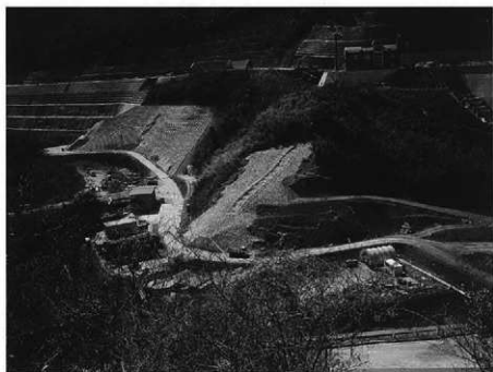
第314図 保存措置後内ヶ磯窯跡全景
