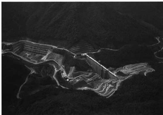
第306図 保存措置後内ヶ磯窟跡と福智山ダム
