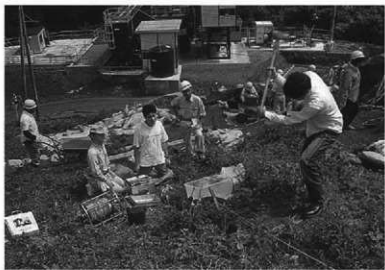
第297図 物理探査作業風景
