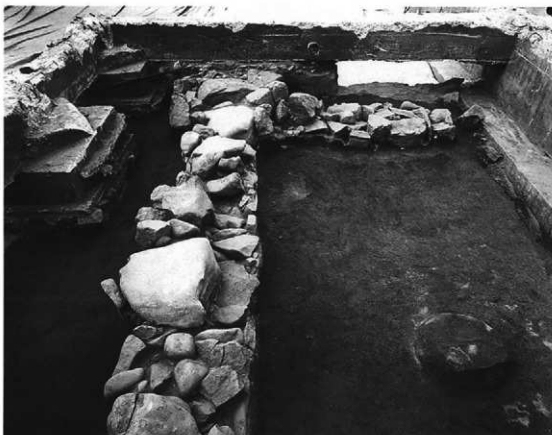
1. 1号旧校舎基礎 (西から)
