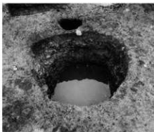
第6号井戸跡完掘 S E
