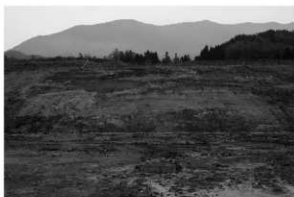
写真 A 工事中の法面 西から
