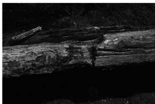
E区 木組1 建築材 拡大
