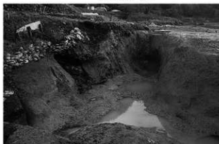
堀区完掘 多方向
