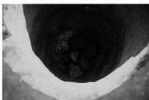
SK52 掘出土状況 E→
