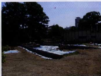
▲発掘調査風景 北西より
