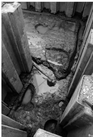
1 調査区北端部完掘状況（東から）
