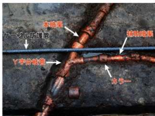
▲⑦医学部百年記念館地点の暗渠。役割を終えた暗渠の上に現代のケーブル防護管が敷設されていた。
