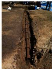
▲ 獣医学研究科大動物実験研究施設地点で発見された土管暗渠の埋設状況
