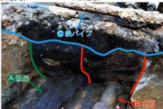
▲明渠の様子。掘った溝の断面から水が染み出て溝に溜まる。
