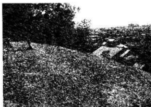
34 填丘盛土完了
