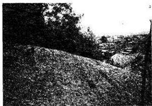
36 填丘芝張り完了
