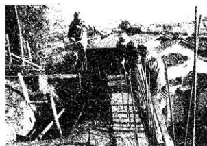
6 擁壁コンクリート打
