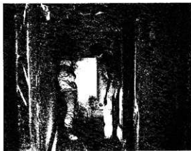
28 内部ウレタン吹付け
