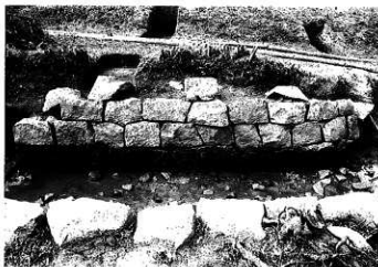
下流石積 右岸 (北東から)
