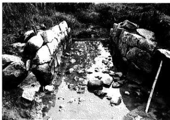
下流石積 (北西から)
