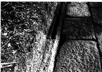
吐井手板石導水堤の凹凸部 (南西から)
