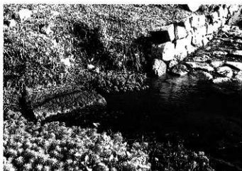
浮田下ノ池からの底樋出口 (南西から)
