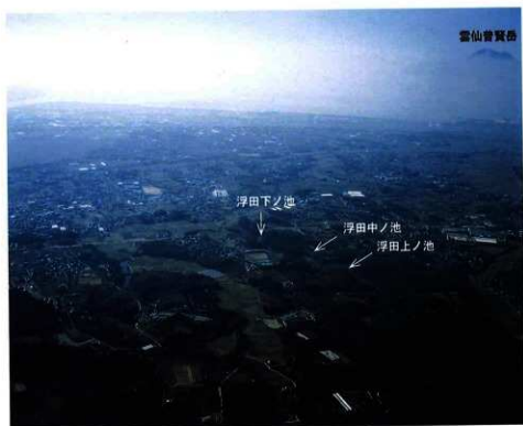
浮田溜池上空から下流受益地を望む（北斜め上空から）
