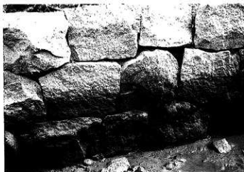
下流石積に残る矢穴痕 (北から)
