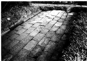
吐井手板石敷 (南から)
