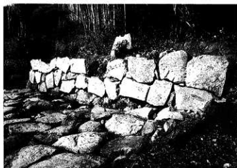
吐井手石積導水堤 右岸 (東から)
