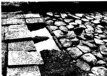
吐井手板石敷止板石 (北から)
