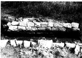
下流石積 左岸 (南西から)
