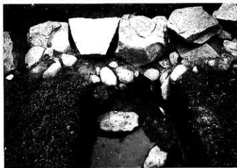
吐井手石積導水堤裏込 (南東から)
