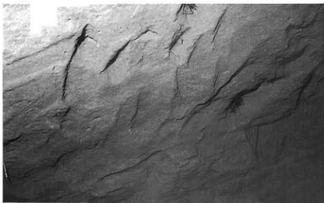
B群1号墓 奥室壁面の工具痕
