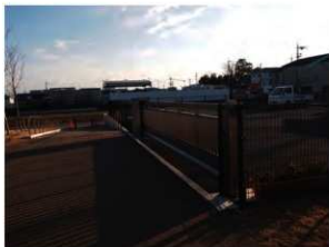
写5-45 倉庫周りの進入防止柵
