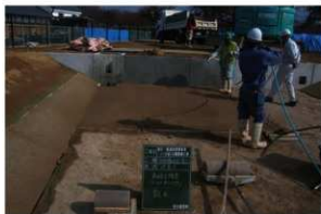
写真 1-39 西側大環濠真砂土固化舗装
