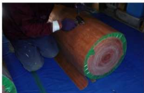
写真1-18 柱素材木目シート貼付1
