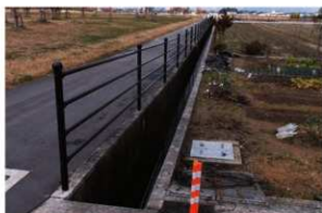
写真1-16 水路工事（開水路）
