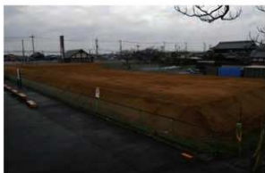
写真1-11 1次造成工事完了
