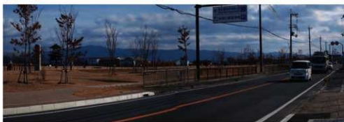
写4-1 国道24号北側から公園を望む
