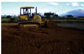
写真1-9 1次造成工事施工中（敷均し）
