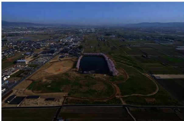
事業完了（南から）
