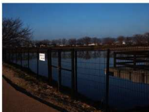
写5-43 唐古池周囲のフェンスh1.5m
