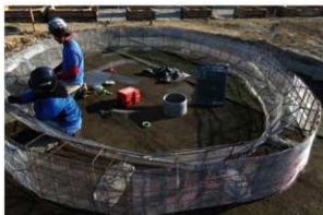
写真1-27 鉄筋・ワイヤーメッシュ張り
