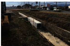
写真1-15 水路工事（ボックスカルバート）施工中
