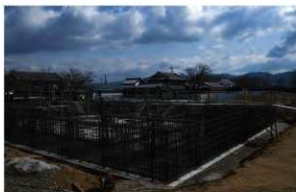
写真 1-49 地下ピット部鉄筋
