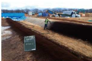
写真 1-43 植生素材吹付
