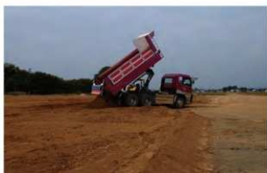
写真1-10 1次造成工事施工中（土搬入）
