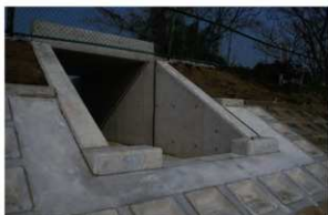
写真1-12 唐古池余水吐・オリフィス
