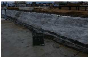
写真 1-46 環濠表現部モルタル荒仕上げ
