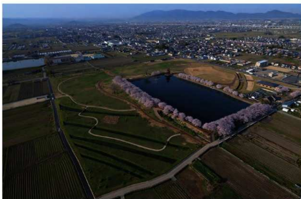
事業完了（北東から）
