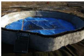
写真1-28 モルタル荒仕上げ
