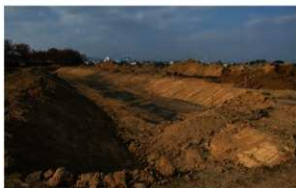
写真 1-33 東側環濠掘削
