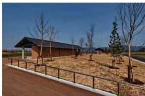
写真 1-67 四阿棟・便所棟
