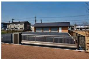
写真 1-71 倉庫棟と管理作業スペース
