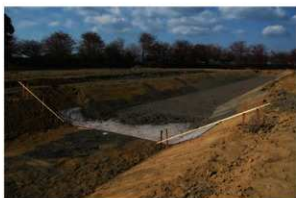
写真 1-35 東側環濠田土貼付け
