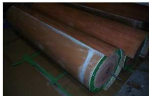
写真1-19 柱素材木目シート貼付2
