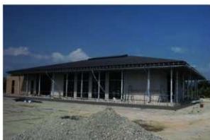
写真 1-51 屋根・壁完了
