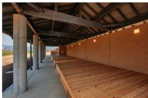
写真 1-70 四阿棟の板敷床
