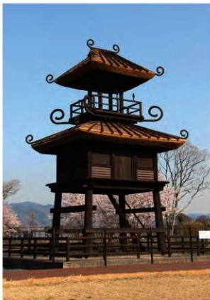
写真1-77 復元楼閣(平成29年度に可単費で改修)
