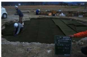
写真1-26 透水シート敷設
