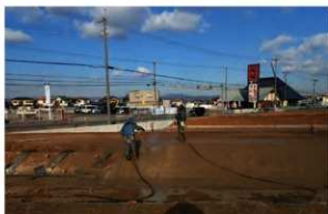
写真 1-42 連続編織補強土
