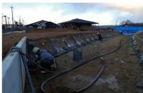
写真 1-41 裏面排水材設置
