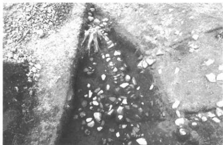
第7トレンチ掘削状況 (東から)
