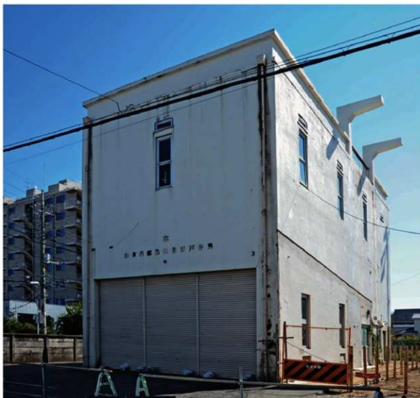
外観 北西から見る
