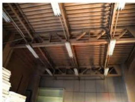
1 階 天井トラス
