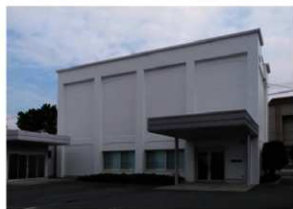
西面 玄関を新たに設け、1階窓は拡張されている
