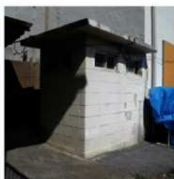
西面に増築されたコンクリートブロック造の便所。撤去後の壁面には黄色仕上げ
