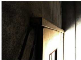
2階外階段からの出入口 当初吊り戸の鴨居。1階出入口にも同様の造作を使用か。2階の戸は更新されている。
