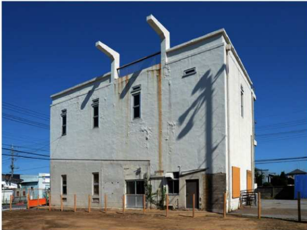
測遠機訓練所 起重機で屋上に測遠機をあげて、遠方の航空機や高い構造物の位置を測定する訓練をした。写真 小林正孝 西面全景 屋上には起重機支柱が立ち、壁面に起重機昇降レール支持材の取り付いた痕跡が残る。 隣地の消防署別棟解体後、高野台町会集会所建設準備中（2015年春撮影）
