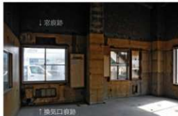
1 階 消防署として利用するために、開口部は大きくされてアルミサッシが建て込まれていた
