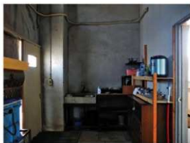
2階出入口脇に人造石研ぎ出しの流しがある
