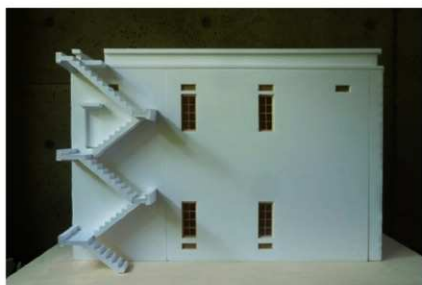
高射砲第2連隊砲空予習室 復原模型 上階（当初は回廊）及び屋上へは外階段である
