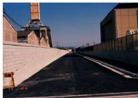
道路を工場敷地の東側に移した1985年に撮影
