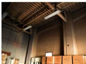
1 階 壁沿いに大梁が架かる
