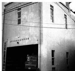
アルミサッシに更新される前の消防署の窓廻り。 上げ下げ窓は木製か。各窓には横桟が1本入る。
