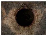
柱面コンセントの痕跡 直径80ミリ
