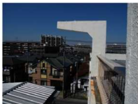
屋上 起重機支柱側面
