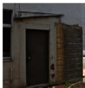
西面に増築されたコンクリートブロック造の便所。撤去後の壁面には黄色仕上げ
