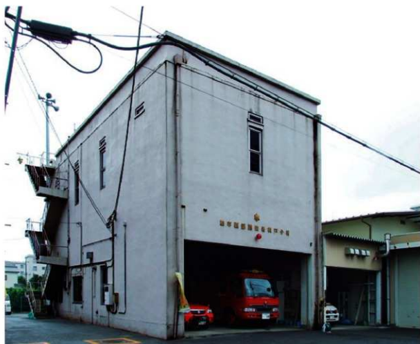
外観 北東から見る 柏市西部消防署観戸分署時 2007年8月
