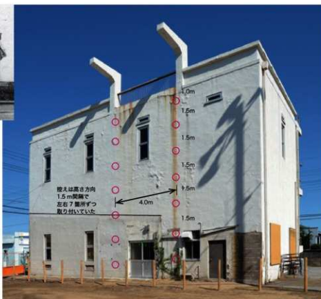
高村砲第1連隊（浜松） 照空予習室に見る起重機 ガイドレール支持材
