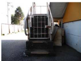
階段 上がり口正面には扉。階段1段目が埋もれている
