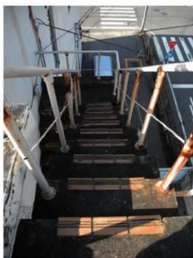
屋上踊り場から下方を見る。 すべり止めタイルが踏面手前角に取り付く。
