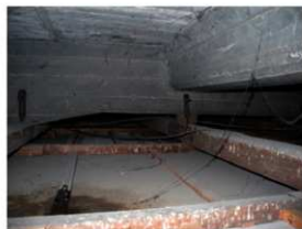
東西に架かる大梁中間に、小梁が取り付け
