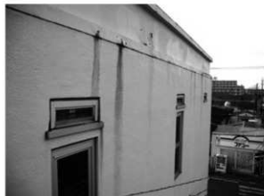
2階の窓上換気口はアルミサッシへの更新時に欄間窓に変更
