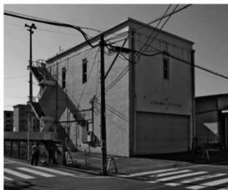
北東から見る 東壁に取り付く外階段で屋上にあがる
