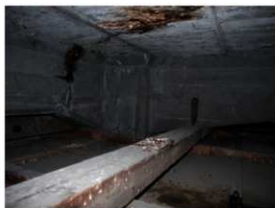
北東隅柱に大梁が2方向から架かる
