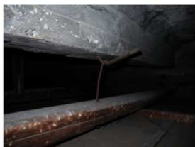
小梁下に突出する鉄筋に野縁受けが取り付けく。 この下に野縁を打ち、天井板を張る。
