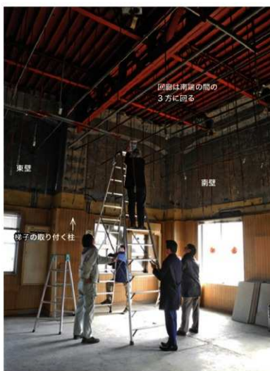
吊り天井撤去後の1階南側 消防署時代の造作を撤去し、はじめて全容が見えるようになった。
