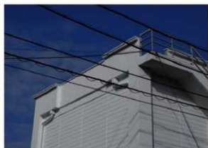
南面には、起重機からの上げ下ろしのために開放されていた バラベットの埋めた跡がある
