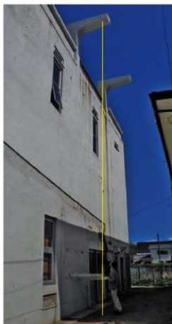
起重機ガイドレール位置検討状況（ガイドレールを加算） 壁に残るボルト切断跡より、控えの位置を確認。壁面より約1メートルとした。
