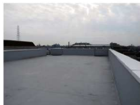
屋上から左図の内側を見る
