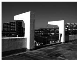
屋上西面にはクレーン支柱が立つ
