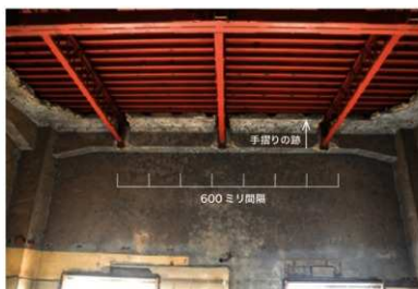
南面の壁を見上げる。回廊の幅、手摺り子が600ミリ間隔で立っていたことがわかる。回廊縁の厚さは120ミリ。 壁面に間接照明を取り付けた痕跡は確認できない。 2階の床を造るデッキプレートは回廊の上のせられている。
