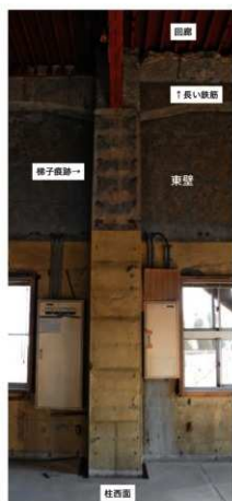
柏市による3Dレーザー測量実施のために天井を解体、回廊と梯子の痕跡が明らかになる。 梯子の取り付いた柱西面。梯子は幅約470ミリで、高さ方向に300ミリの間隔で取り付いていたことが読みとれる。
