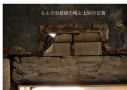
1 階 室内では、拡張された窓開口部上方に、額縁を取り付けた痕跡が残っていた。コンクリートに木片が埋め込まれている
