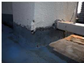
屋上 起重機支柱足元に残る耐震金物。各支柱の内法下方と農高（現在の増ぐらいの高さ）に残る
