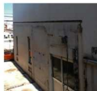
西面、南から見る。消防署車両の痕跡
