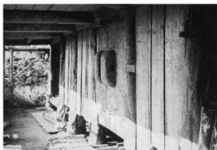
第16図 沖縄県具志川村の倉庫扉
