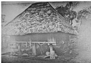
第12図 東京都八丈島の民家
