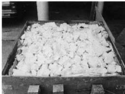
写真47 裏面に細切ファイバーを詰める(南)
