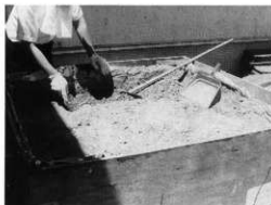
写真44 裏側の土を除去、掘りや易い(南)
