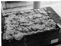
写真32 16缶でようやく充填完了(北)
