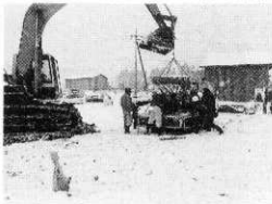
写真22 1tトラックに積み込む(北)
