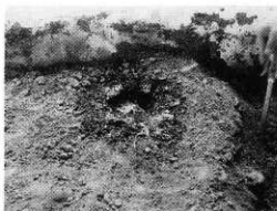
写真37 穴のあいた所にファイバーで蓋をする
