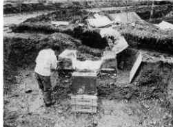
写真17 手前にストーブ、ファイバー硬化促進
