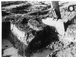
写真14 パワーショベルで掘削（南）
