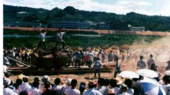
▲ 修繕で巨石を運ぶ様子 (大阪府)
