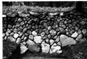
6 2トレンチ石垣検出状況
