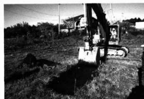
7 表土掘削状況
