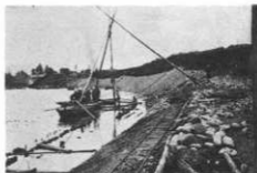
護岸工事をする作業船 (利根川)
