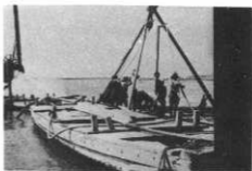
護岸工事をする作業船 (利根川)
