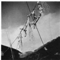
空中に吊り上げる
