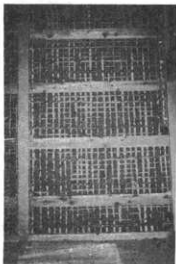
〔写真3-23〕 真壁の荒壁（裏からみた）
