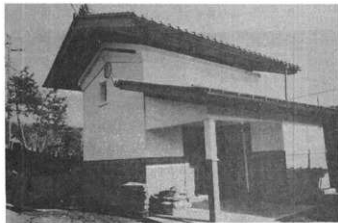
〔写真3-22〕土蔵造りの完成
