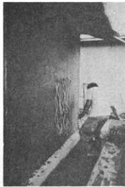
〔写真3-17〕 下げ籠の塗り込み
