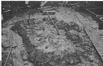
〔写真3-14〕 荒打ち土練り
