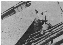
〔写真1-3〕妻部の破風を小鉄で仕上げているようす
