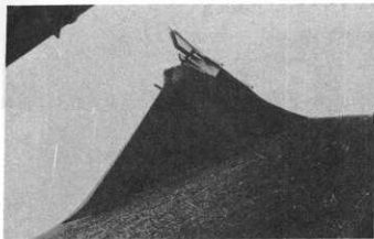
〔写真1-19〕八字破風（この破風は風格を有するので江戸時代は名主等村役人以上にしか許されなかったものである）
