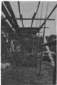
〔写真1-5〕足場のようす
