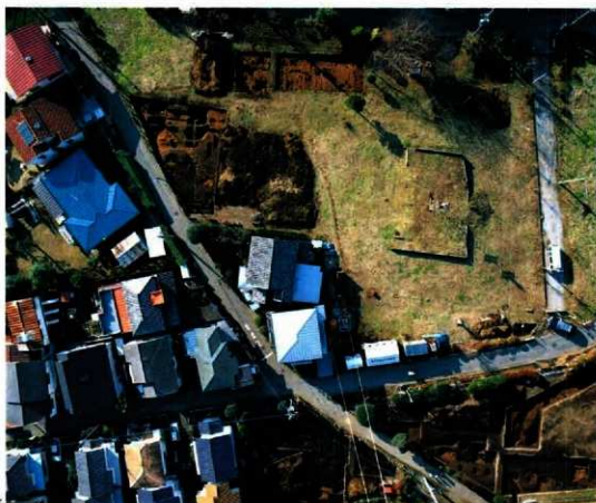
1. 金堂・中門付近全景
