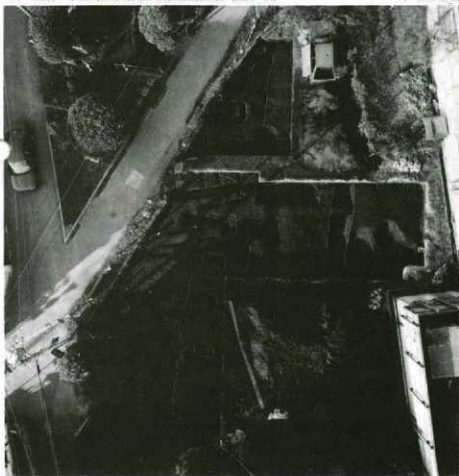
2. 中枢部区画東辺地区南側全景
