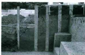
深掘区（立体駐車場建設部分）西壁断面
