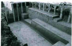
深掘区（立体駐車場建設部分）全景
