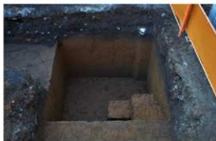
5 1号試掘坑完掘全景（北から）
