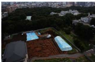
7-6 B-2区縄文確認面調査終了全景（西から）
