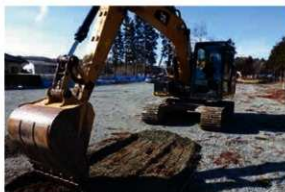
写真88 重機掘削状況
