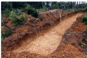
写真33 3T調査状況
