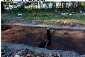
写真55 10T-S I 2調査状況
