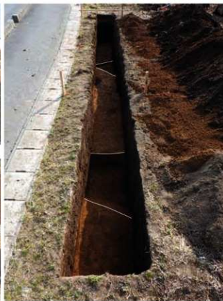
写真97 2 T 調査状況（古墳周溝検出状況）
