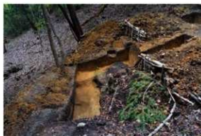
写真39 10T 調査状況
