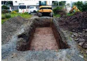
写真59 1T調査状況
