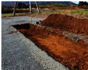
写真115 1T調査状況
