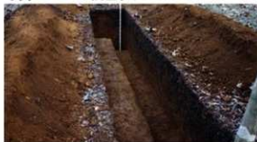
写真152 6T調査状況
