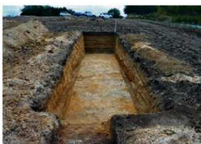
写真125 2 T 調査状況
