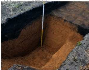
写真150 2T断割り状況
