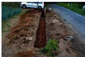
写真78 1T調査状況
