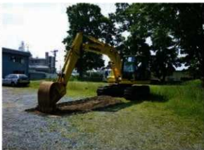
1. 表土除去作業
