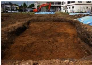
2. 1 T 調査状況
