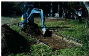
6. 表土除去作業
