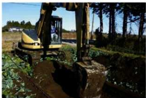
2. 表土除去作業
