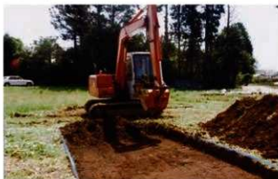
3. 表土除去作業
