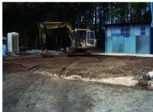
5. 埋め戻し作業
