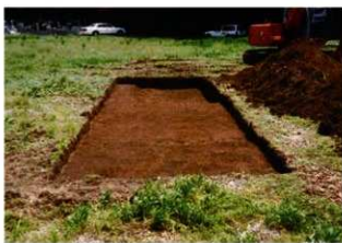
4. 1 T調査状況
