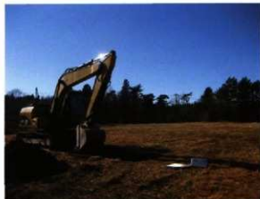
写真 102 重機掘削状況
