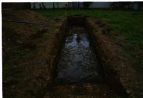
写真 135 1 T 調査状況
