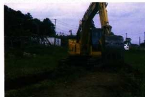
写真 55 重機掘削状況
