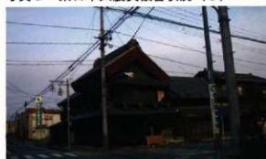
写真11 東日本大震災被害状況(11)
