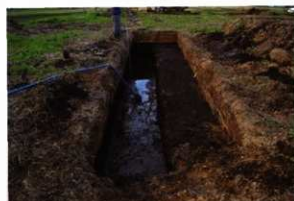
写真 143 11 T 調査状況
