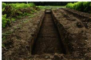
写真 73 8T 調査状況
