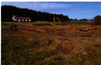
写真 160 作業風景遠景
