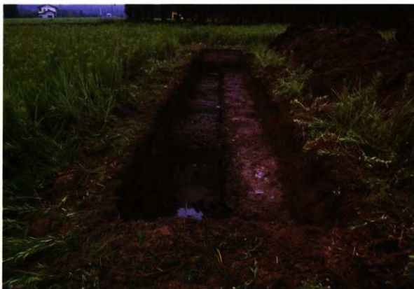
写真 96 1T 調査状況
