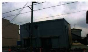
写真12 東日本大震災被害状況(12)
