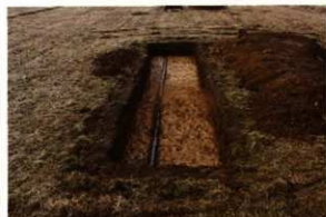
写真 190 4 T 調査状況
