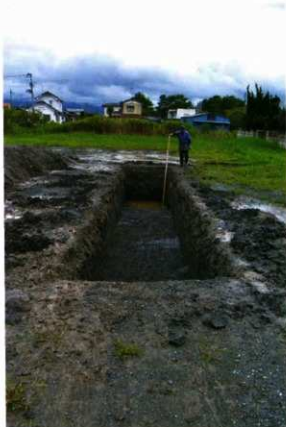
写真 242 1 T 調査状況
