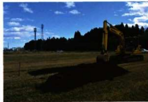
写真134 重機掘削状況
