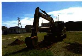
写真 212 重機掘削状況
