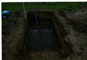
写真 137 3 T 調査状況
