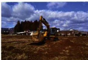
写真 194 重機掘削状況
