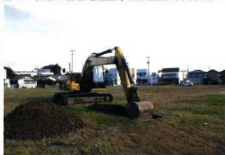
写真 25 重機掘削状況 (H24 大町地区)
