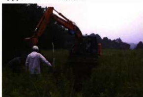
写真 99 重機掘削状況
