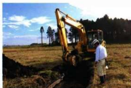
写真 28 重機掘削状況
