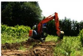
写真 78 重機掘削状況
