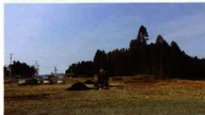
写真 256 重機掘削状況
