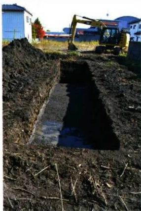
写真 248 2T 調査状況
