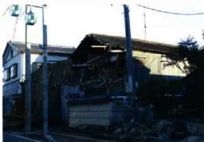
写真5 東日本大震災被害状況 (5)
