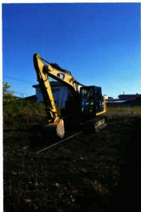
写真 246 重機掘削状況
