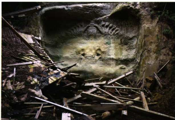
写真1 東日本大震災被害状況(1)
