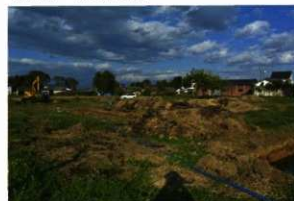
写真133 重機掘削状況
