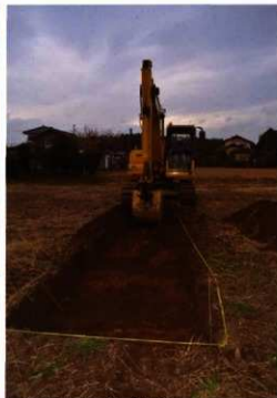
写真 159 重機掘削状況
