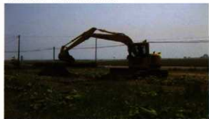
写真 291 重機掘削状況
