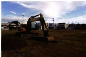
写真 232 表土除去作業
