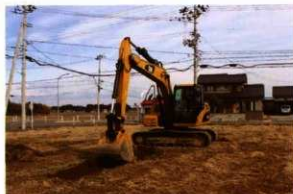
写真 186 重機掘削状況
