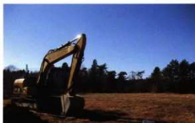
写真22 重機掘削状況 (H25 北泉地区)
