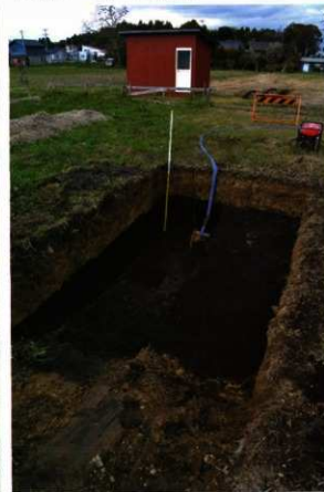
写真 140 8 T 調査状況
