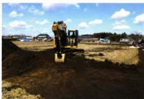
写真 153 重機掘削状況 (A区)
