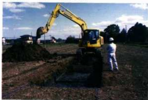
写真 71 重機掘削状況
