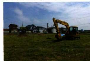
写真 175 重機掘削状況
