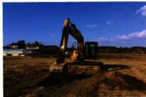
写真 114 重機掘削状況
