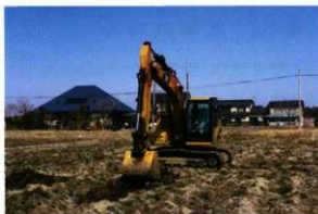
写真 58 重機掘削状況
