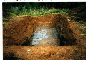
5 5号トレンチ (西から)
