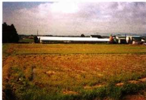
1 遺跡近景 (北から)
