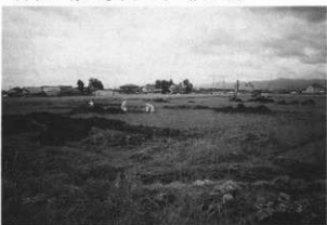
写真16 作業風景 (北東から)
