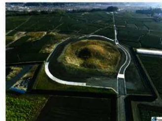
29年度工事終了 西から
