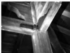
横架材 接合部補強 (抜け防止)
