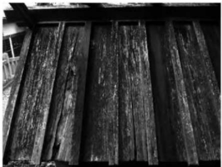
修理前 屋根板の腐朽（背面）
