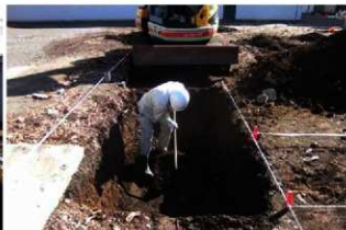
8. 表土掘削作業 (北から)
