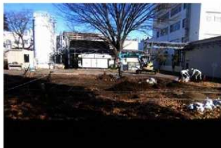
7. 調査着手前現況 (南から)
