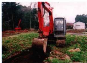
2 表土除去作業
