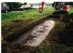
4 2 T 調査状況
