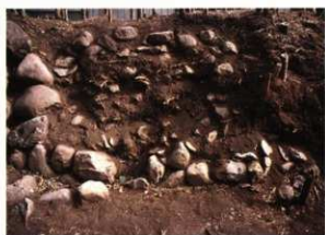
3 石垣崩落状況
