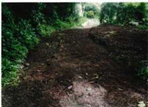
5 埋め戻し状況
