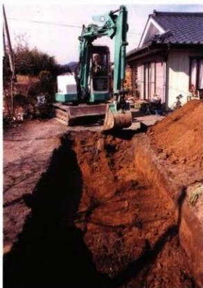
4 埋め戻し作業
