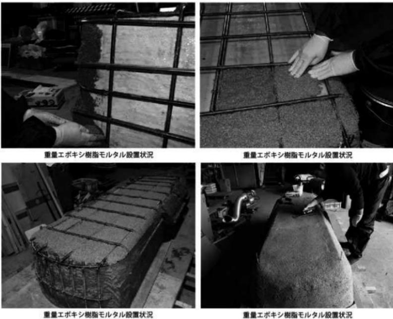
配筋完了後、ステンレスボルト周囲に重量エポキシ樹脂モルタルを2～3層に分けて塗り付け石棺の大まかな形状を復元した。
