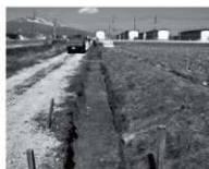
①掘削状況
