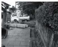
①掘削状況
