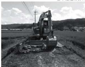
⑥中道遺跡群30 掘削状況
