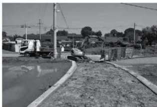
⑨大中沢遺跡7 掘削状況
