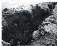
④掘削状況
