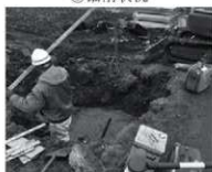
⑨掘削状況
