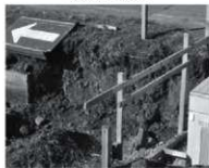
⑥掘削状況
