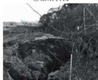
⑧掘削状況
