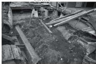
建物解体状況
