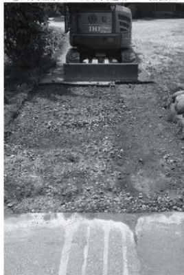
⑧ 地家遺跡 5 掘削状況
