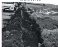
⑩掘削状況
