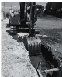
鳴潭遺跡群21 掘削状況
