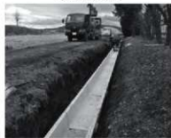
⑦掘削状況
