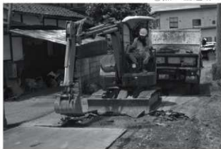
④中原遺跡6 掘削状況
