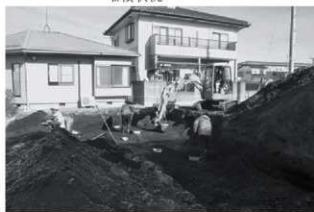
遺構調査状況
