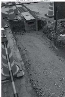
⑩城下遺跡14 施工状況
