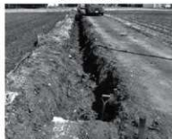
⑤掘削状況
