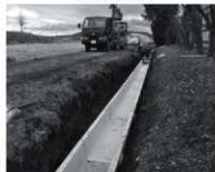
⑦掘削状況
