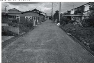
⑤熊の堂遺跡 8 施工状況
