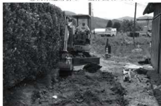
①筒畑遺跡群 9 掘削状況
