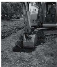
①鳴瀬中屋敷遺跡群7 掘削状況
