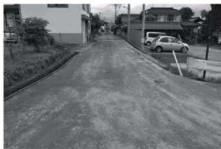
⑨大沢屋敷遺跡4 施工状況
