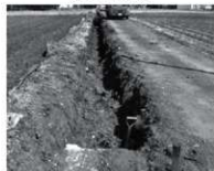
⑤掘削状況
