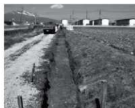
①掘削状況
