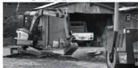
②横道上遺跡1 掘削状況
