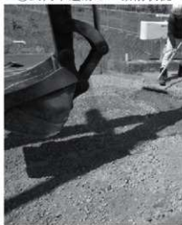
①大門下遺跡5 掘削状況
