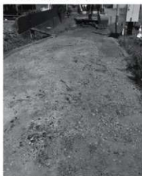
①大門下遺跡5 掘削状況
