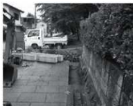
①掘削状況
