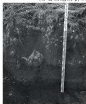
擁壁設置箇所堆積状況
