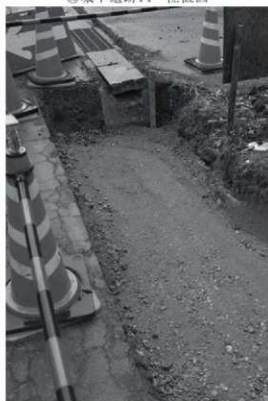
⑩城下遺跡14 施工状況
