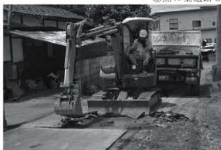
④中原遺跡 6 掘削状況
