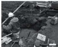
⑨掘削状況
