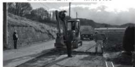
③西藤巻遺跡1 掘削状況
