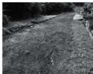
②掘削状況
