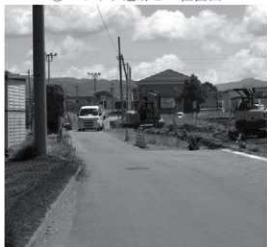
②寺畑遺跡群42 掘削状況
