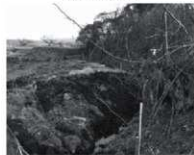
⑧掘削状況
