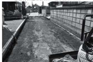
②岩村田遺跡群316 掘削状況
