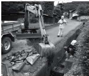
⑦象ヶ岡遺跡2 掘削状況
