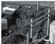
⑥掘削状況
