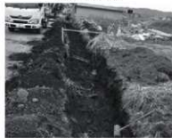
⑩掘削状況
