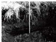
写真96 2T断面(W→)
