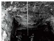
写真161 2T断面(W→)
