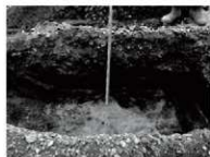
写真50 3T断面(W→)
