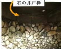
石の井戸枠 井戸内部の様子(上)
