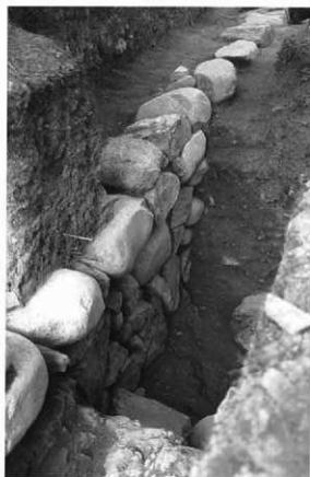
14 T-2 虎口東側石積検出状況② (北から)
