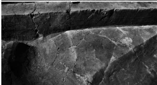
2. 60号墳 墳丘 ・西側周溝 断面 (南から)
