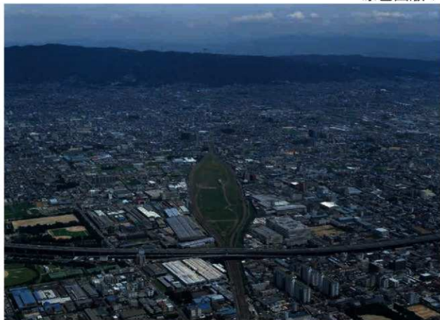
1. 電華操車場調査前風景 (1996年 撮影) 北西から
