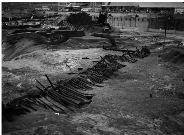
2. 上流側 全景（南東から）
