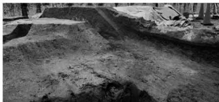
3. 後方部墳丘北側 断面（東から）
