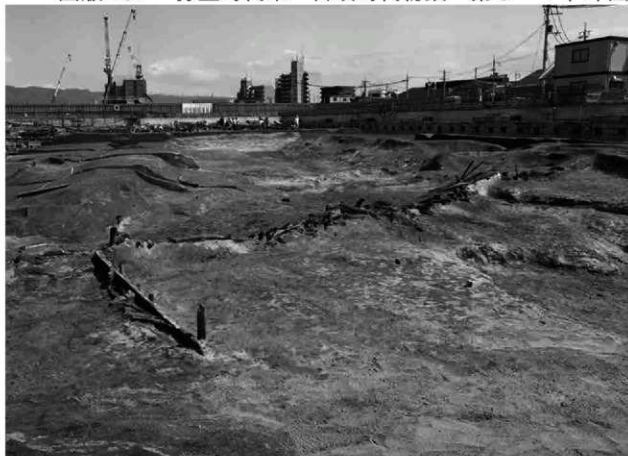
05423 塚：1. 下流側 全景（北西から）
