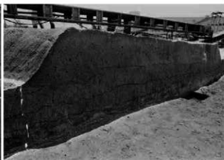
5. 01106 島島 断面 (東から)
