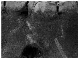
1. 噴砂 断面(南から)
