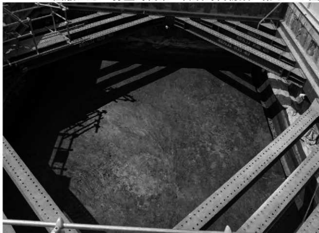
1. 01-4調査区（北から）
