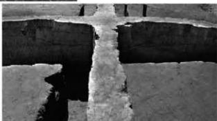
6. 墳丘・主体部① 断面 (北から)
