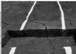
2. 080908溝 断面⑤ (北から)
