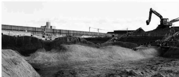
7. 09003 流路 断面 (北西から)
