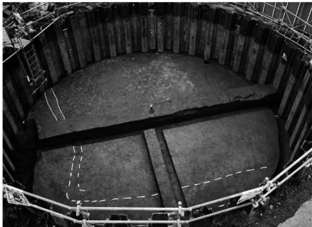
2. 02-2 調査区 (北東から)
