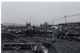
写真6 測量杭 打設風景
