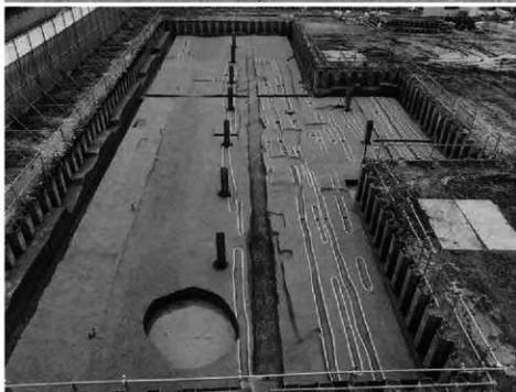
3 2 調査区 第 3 面 検出状況
