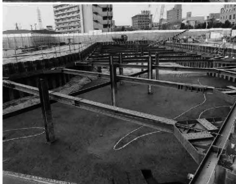
2 1調査区 第8面中央 検出状況
