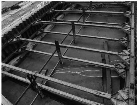
1 1 調査区 第11面西半 検出状況 北東から
