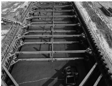
1 1調査区 第10面西半 検出状況 西から
