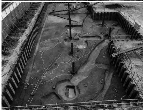
2 2調査区 第6-2面 西半 検出状況 西から
