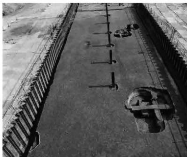
1 1調査区 第5面西半 検出状況 西から
