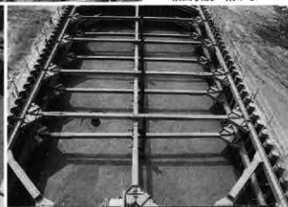
4 3調査区 第15b面 検出状況 東から
