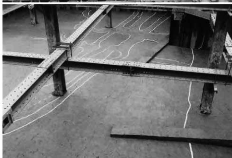
2 2調査区 第15面 2-144～153溝 検出状況 北から
