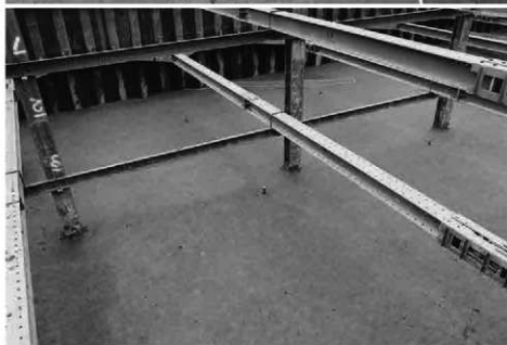
3 1調査区 第15面 検出状況 南から
