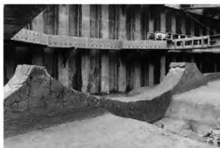
5 1 調査区 1-407溝・408・406高まり 断面 南西から
