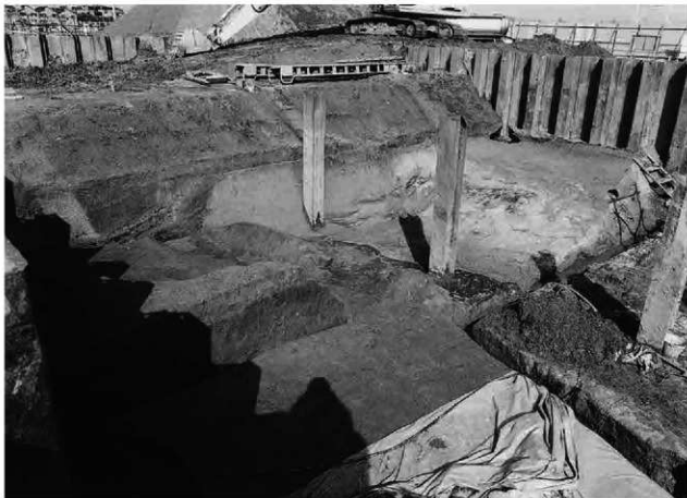
1. 05-2-2区 337流路上部上方 (南東から)
