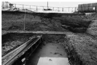
2. 4区 337流路断面 (東から)
