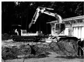
2. 表土除去（東から）
