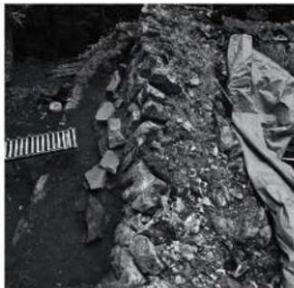
写真6 盛土核礫と1号風穴石積み西側
