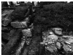
図8 石垣の上下層に小礫がある状況（西から） 下層は裏込め、上層は崩落してきたもの。
