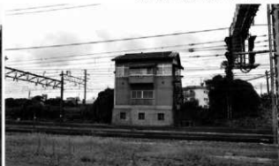
第6信号扱所（南東から）
