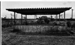
第2職員地下通路出入口（北西から）
