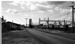
待機中の列車（右）と休憩所（左）（北東から）
