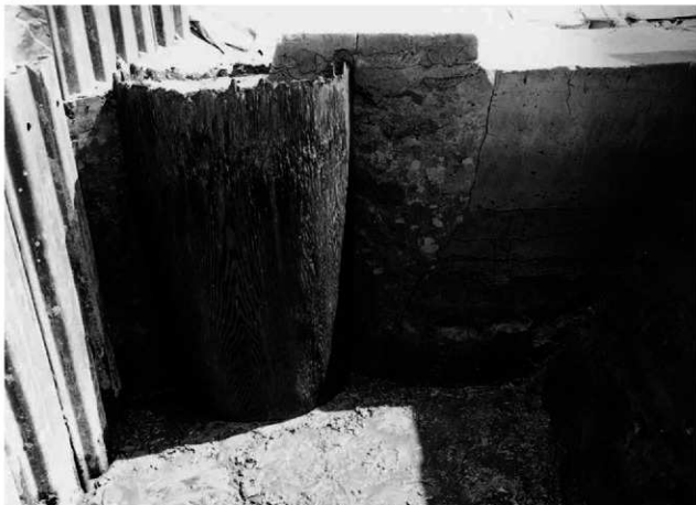
1 385井戸断面1 (北から)
