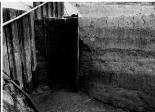
3 井戸断面2 (北から)
