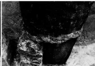
4 井戸枠を縛る紐 (北から)
