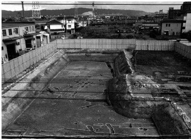
5. 第3面 全景 (西から)
